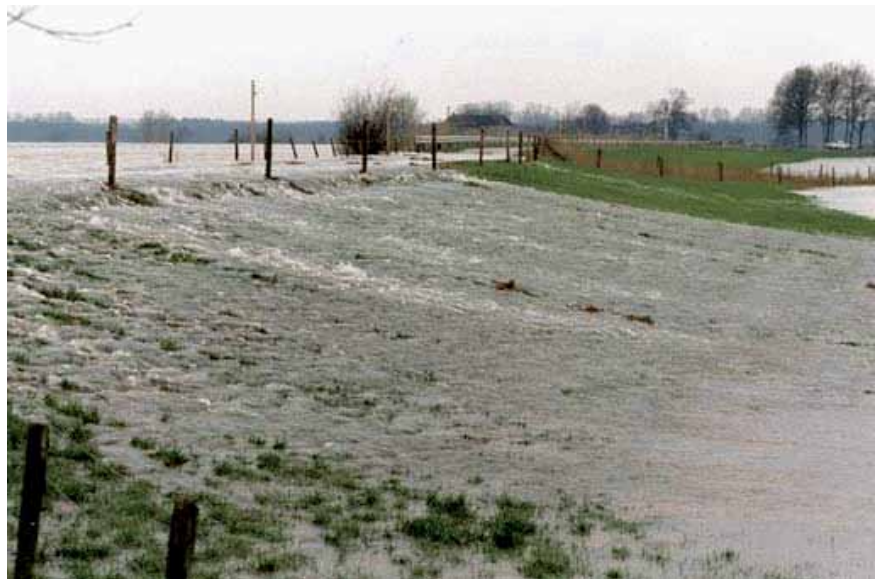
Figuur 2-7 Een overstroming door het overlopen van een dijk
