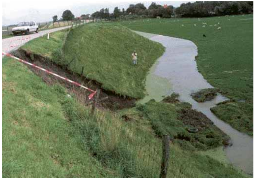
Figuur 2-11 Voorbeeld van het afschuiven van het binnentalud.
